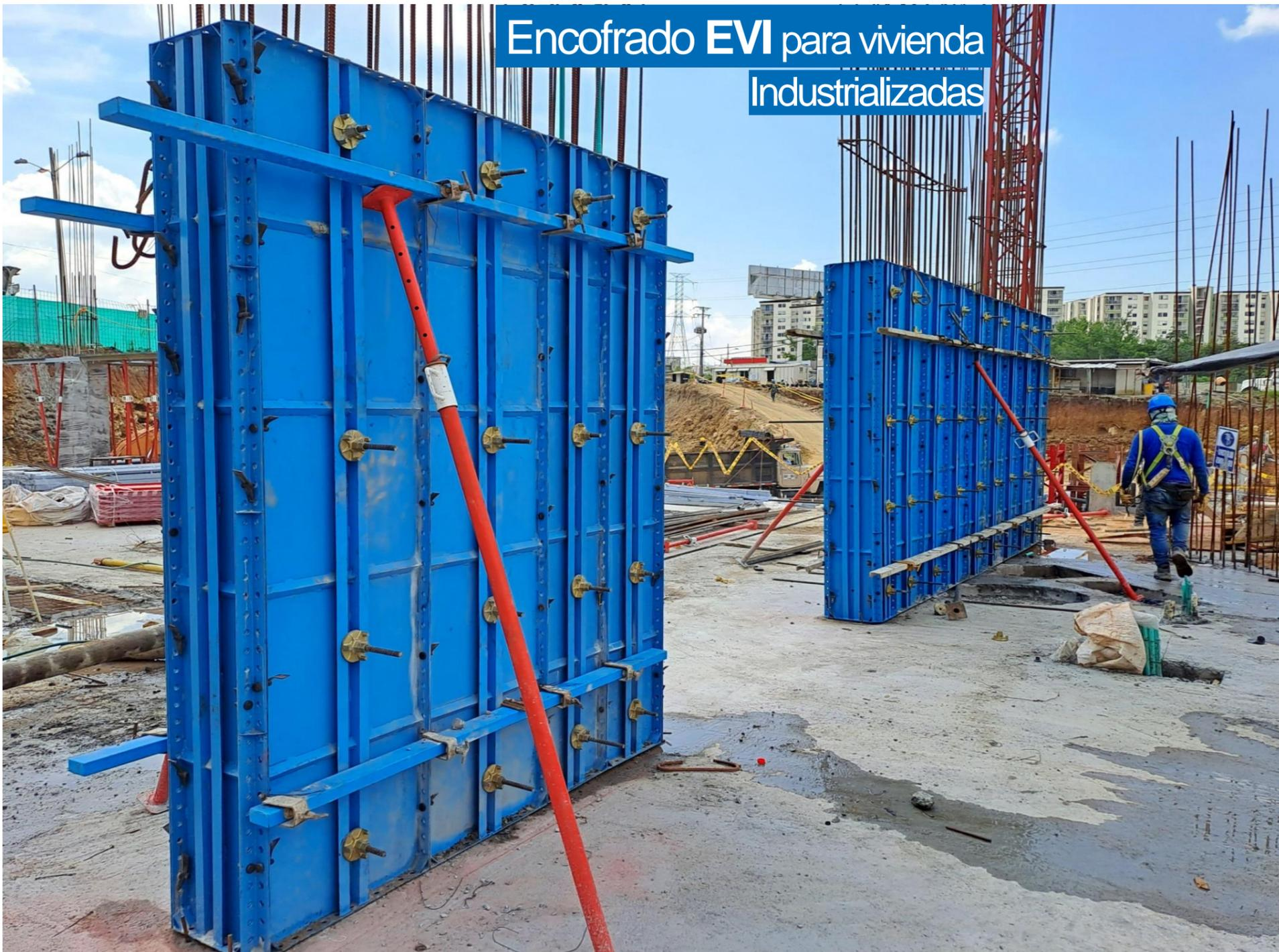
Ideal para el armado de muros de vivienda industrializada, una opción **rápida, segura y confiable** que garantiza el **máximo rendimiento en obra.**
