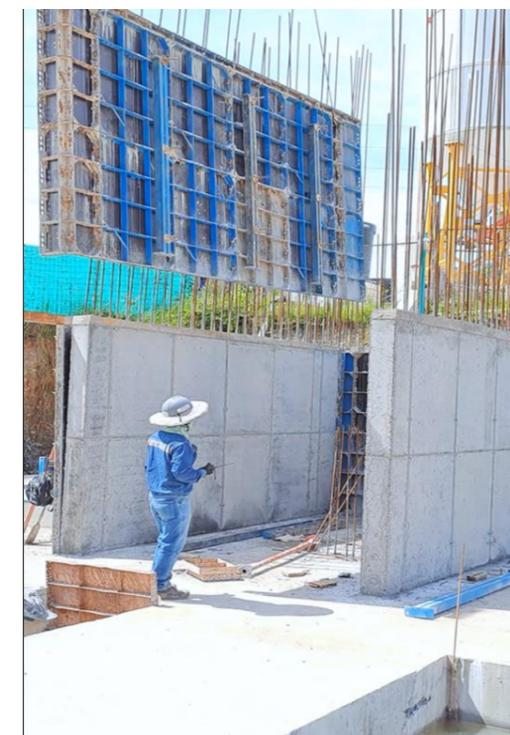
Ideal para alzado de módulos de muros completos...
